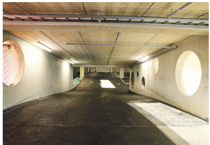
På denne kjørerampen mellom etasjer ser vi de solide betongkonstruksjonene produsert i lavkarbobetong av Veidekke prefab på Klepp.
