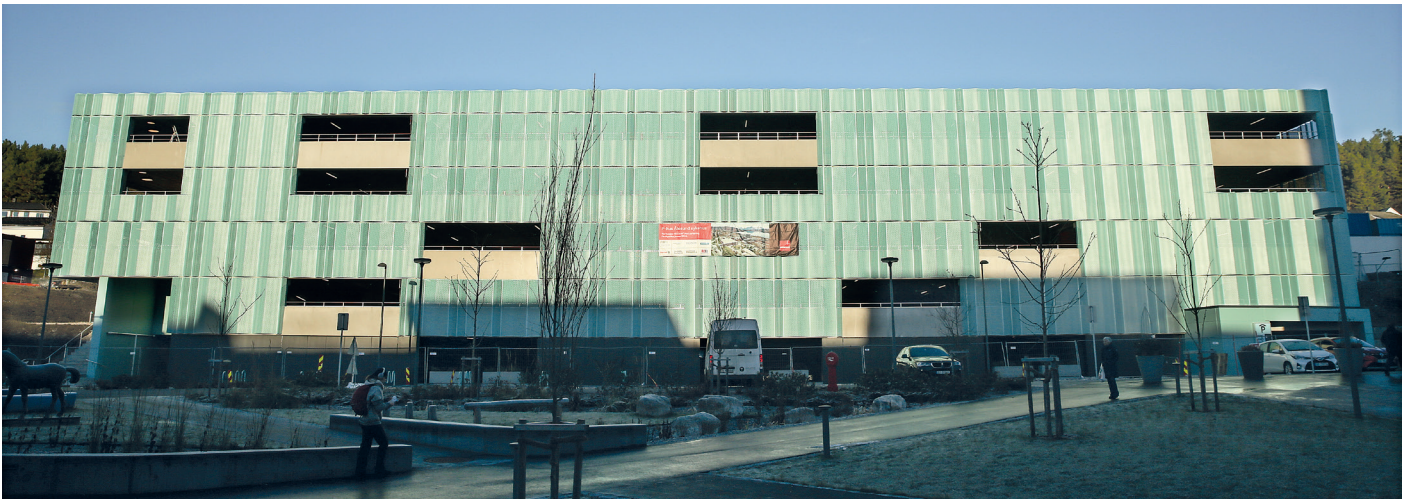
Det nye parkeringshuset ved Ålesund sjukehus sett fra fronten mot sør, fra området ved hovedinngangen til sjukehuset.
