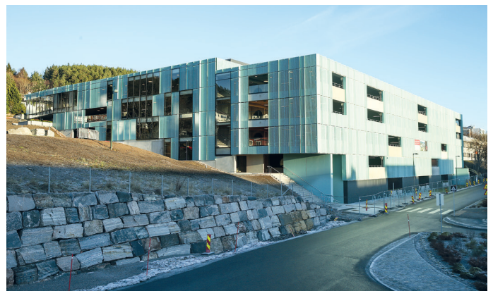
P-anlegget med plass til nesten 600 biler sett fra bakkeplan mot sør-vest. Glassfasaden er levert av Straumsheim Glass og Fasade.
