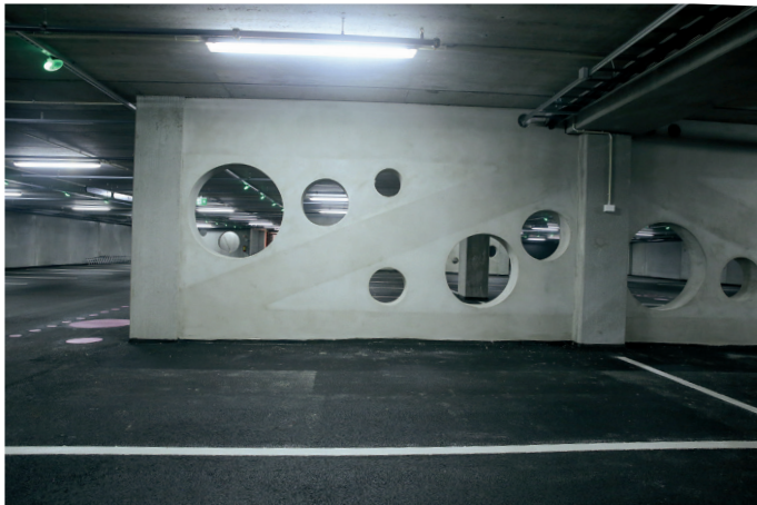
Sirkler er et gjennomgående tema i det nye parkeringshuset. Sirklene går igjen både i betongkonstruksjonene og i den taktile merkingen.
